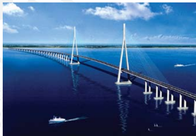
Название: Sutong (через реку Янцзы)
