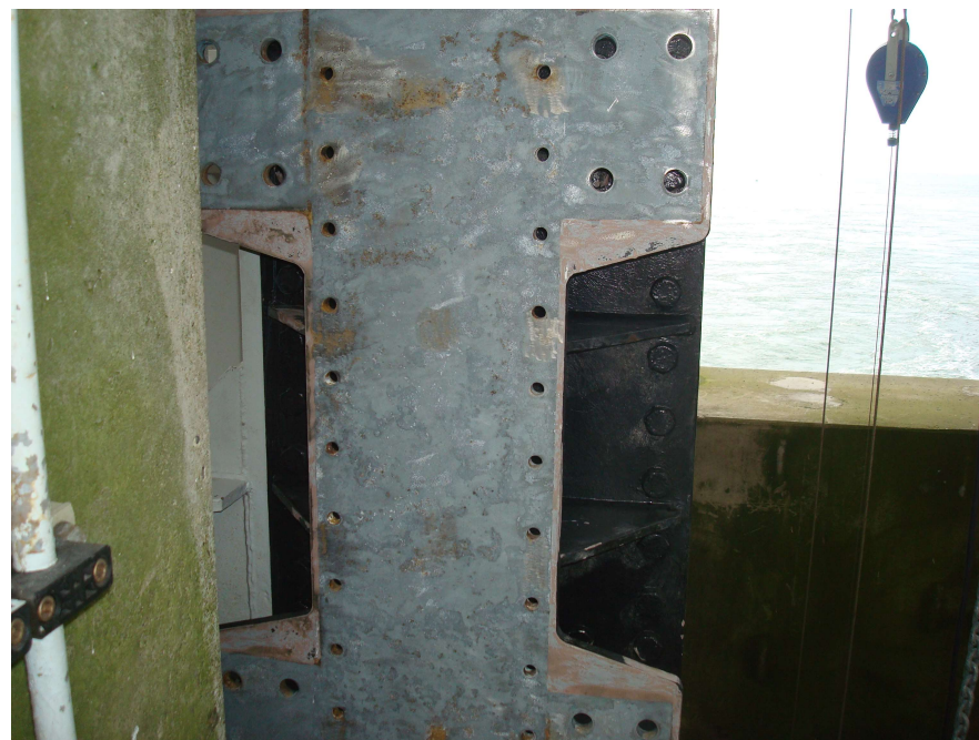
Фото: Ремонтные работы, 2012 г.
